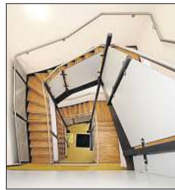
Neu: Während das vordere Treppenhaus bereits vorhanden war, musste dieses zweite Treppenhaus aus Brandschutzgründen gebaut werden.
